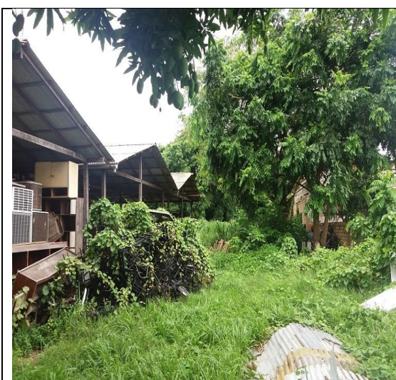
Foto – vista do interior do imóvel, Santarém/PA, 02 de fevereiro de 2018.
