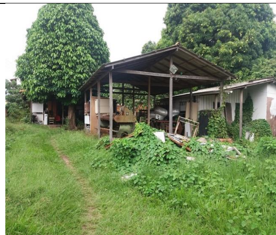
Foto – vista do interior do imóvel, Santarém/PA, 02 de fevereiro de 2018.
